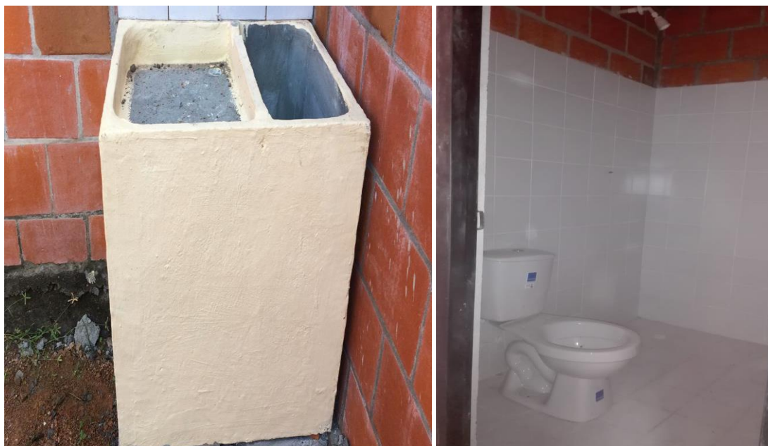
17.0 instalación de alberca y aparatos sanitarios con enchape en zona húmeda.
