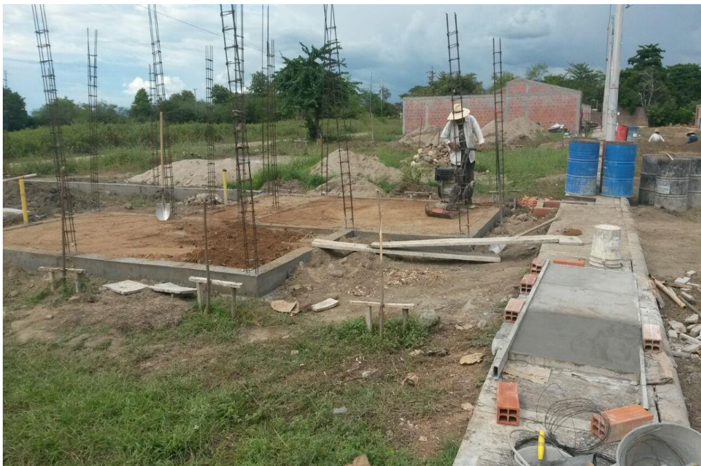
4.0 Conformación de relleno para placa de contrapiso.
