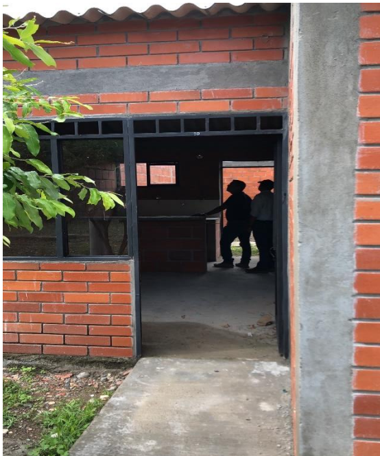
15.0 Carpintería metálica en lamina Cold Rolled cal 20. Para puertas y ventanas.
