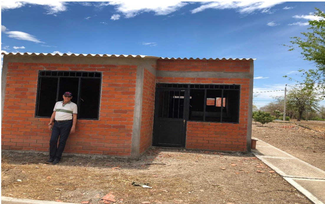
14.0 fachada principal en mampostería bloque prensado en arcilla cocida
