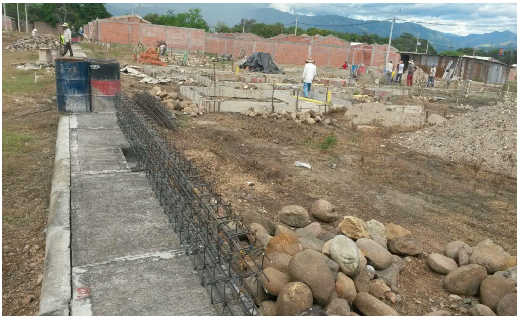
3.0 Armado aceros de refuerzo de \frac{1}{2} , \frac{1}{4} , \frac{3}{8} , Fy 4200Mpa Fc 21 Mpa para vigas de cimentación
