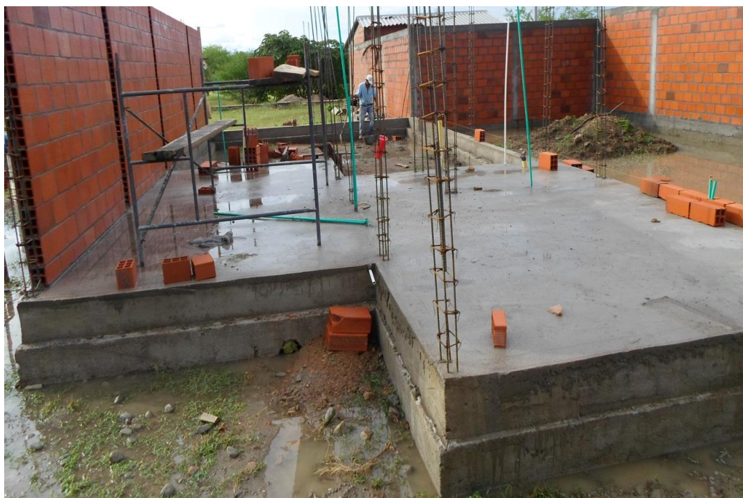
6.0 Placa de contrapiso fundida concreto Fc 21 Mpa, sobre ciclópeo y viga de cimentación.
