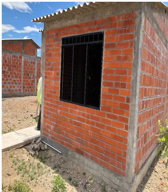
15.0 Carpintería metálica en lamina Cold Rolled cal 20. Para puertas y ventanas.
