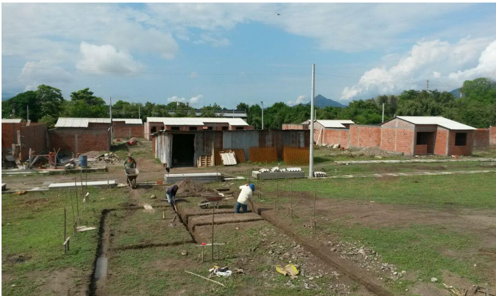
1.0 Obras preliminares descapote, replanteo y excavaciones para cimentación.
