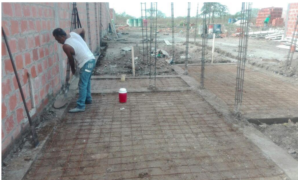
5.0 Instalación malla electrosaldada 5.5mm de .15*.15m placa de contrapiso
