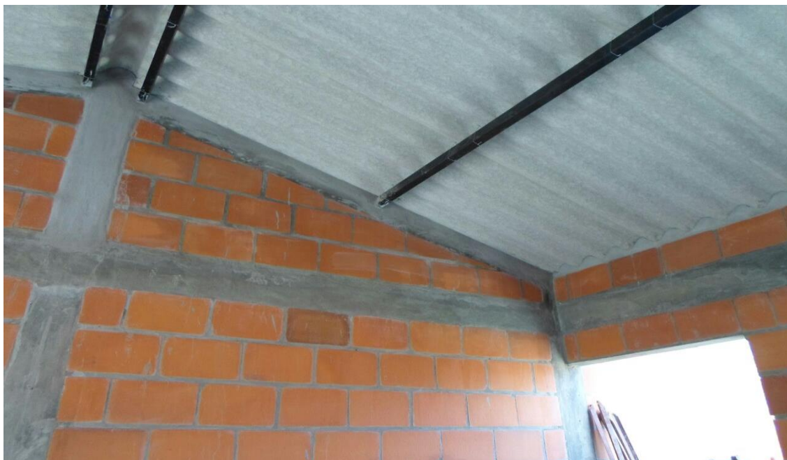
12.0 Viga cinta viga aérea y estructura en correa metálica para cubierta en fibrocemento.
