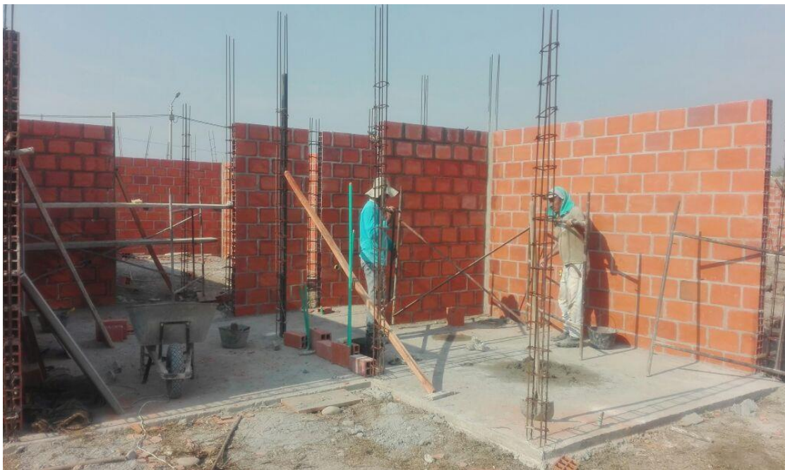
7.0 Acero de refuerzo Armado aceros de refuerzo de \frac{1}{2} , \frac{1}{4} , \frac{3}{8} , F_y 4200Mpa F_c 21 Mpa para columnas de confinamiento de muros en mampostería.
