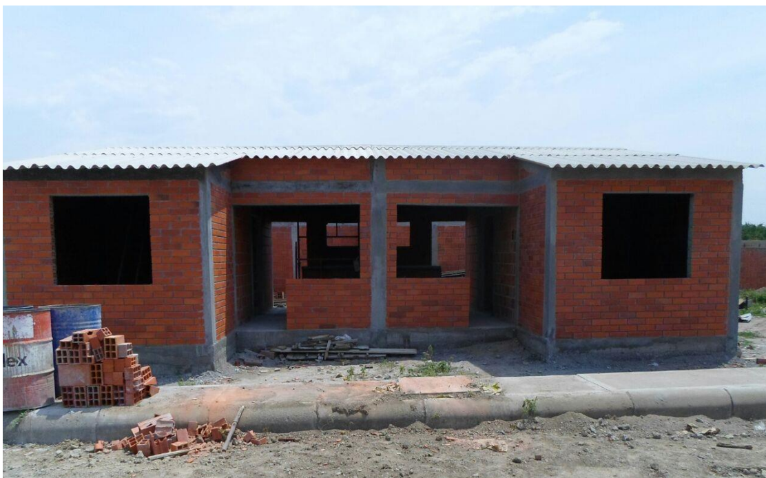
13.0 cubierta de viviendas en fibrocemento.
