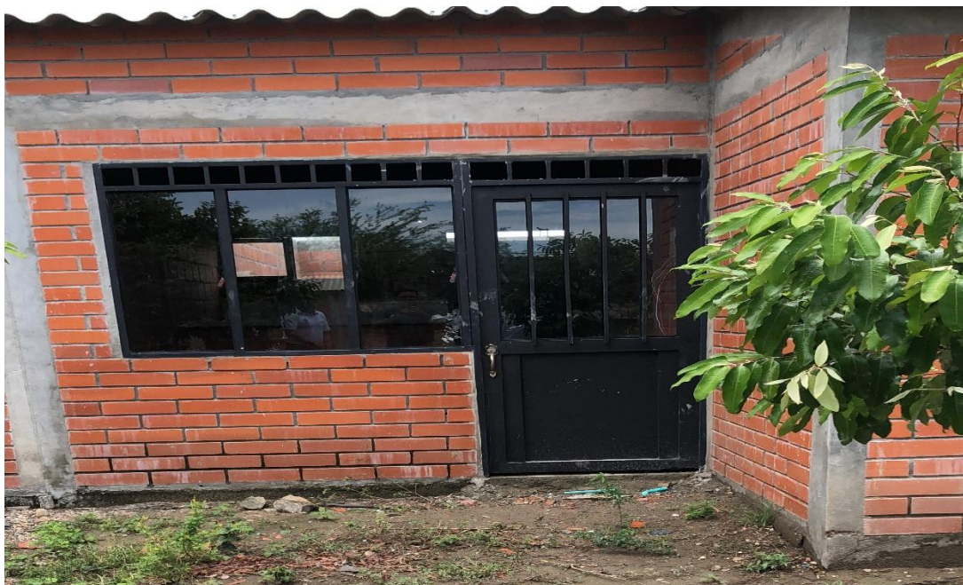
18.0 Puertas y ventanas con vidrio instalado
